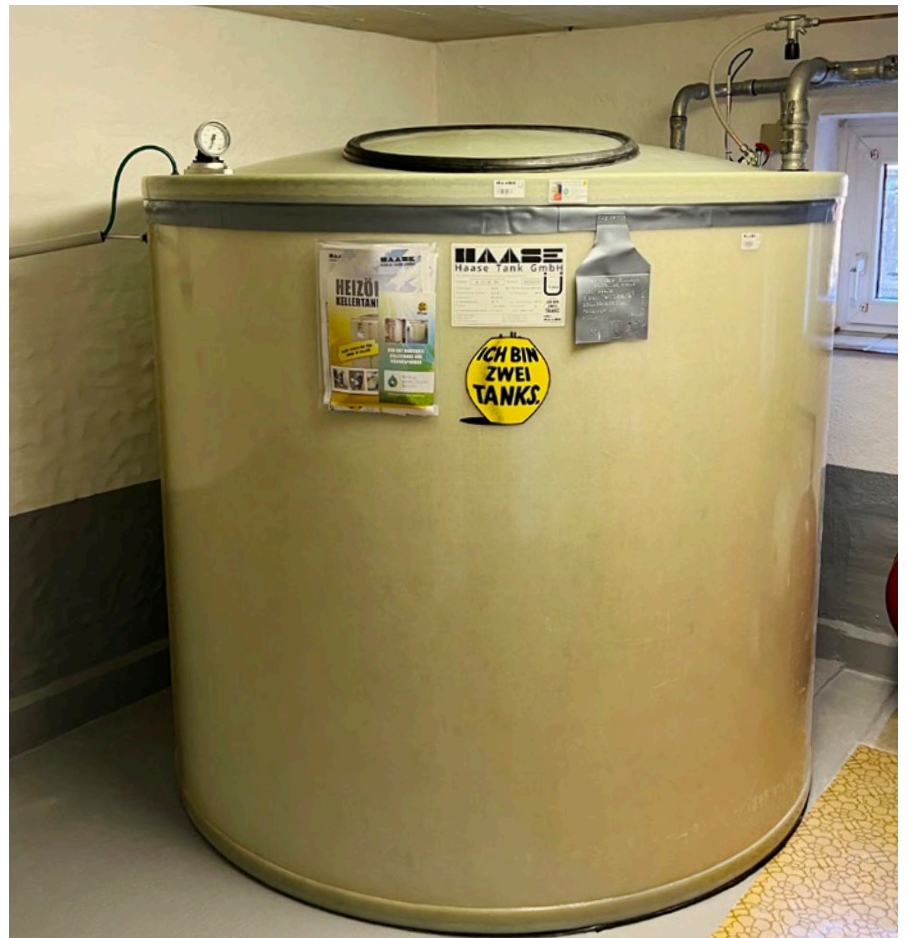
Der doppelwandige Kompakt-Tank von Haase benötigt keine Auffangwanne
